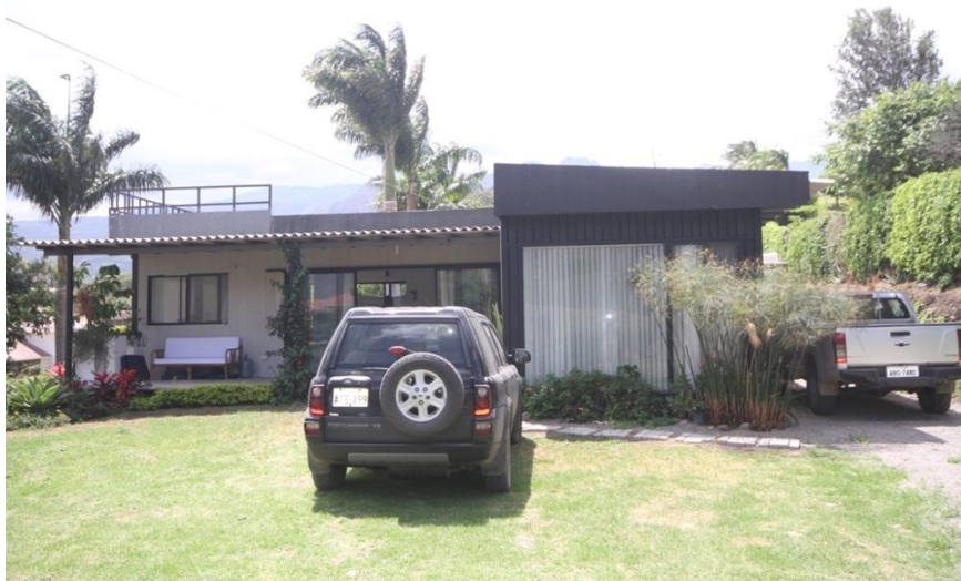
Fotografía No. 16. Imagen frontal de la casa construida con contenedores. Fuente: Trabajo de campo
