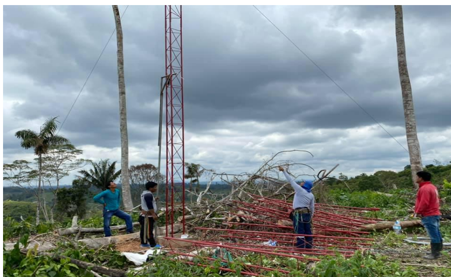
Foto N° 10. Trabajadores chachis instalando antenas de internet. Fuente: Trabajo de campo
