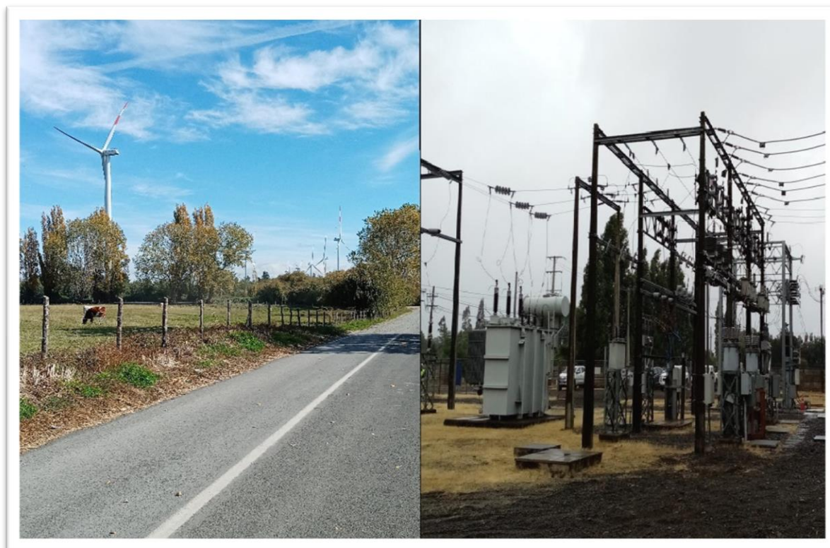
Foto 3.2. Camino rural asfaltado y aerogenerador del PE La Esperanza (izquierda) y subestación Negrete (derecha)
