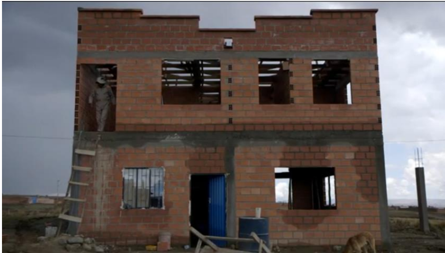
Foto 3.6. Casa en obra gruesa
