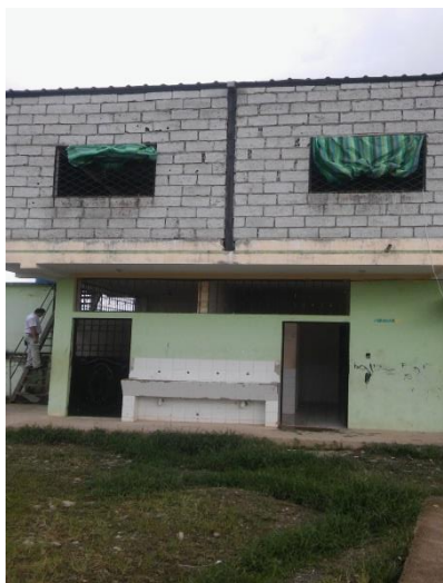
Vista externa del aula de 7mo B
