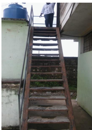
Escaleras para acceder al 7mo B
