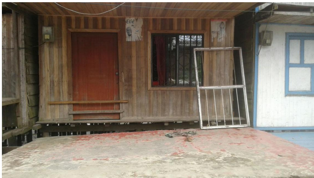
Figura 2.3. Antigua “casa de pique” de la calle de Puente Nayero, Buenaventura, Colombia 14
