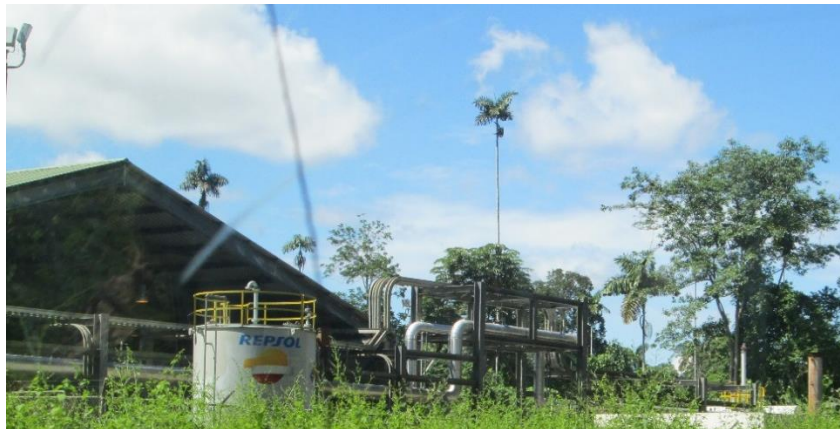
Figura 3.7. Estación de bombeo de Repsol YPF que conecta al bloque 16 con el bloque 15 en Pompeya Sur
