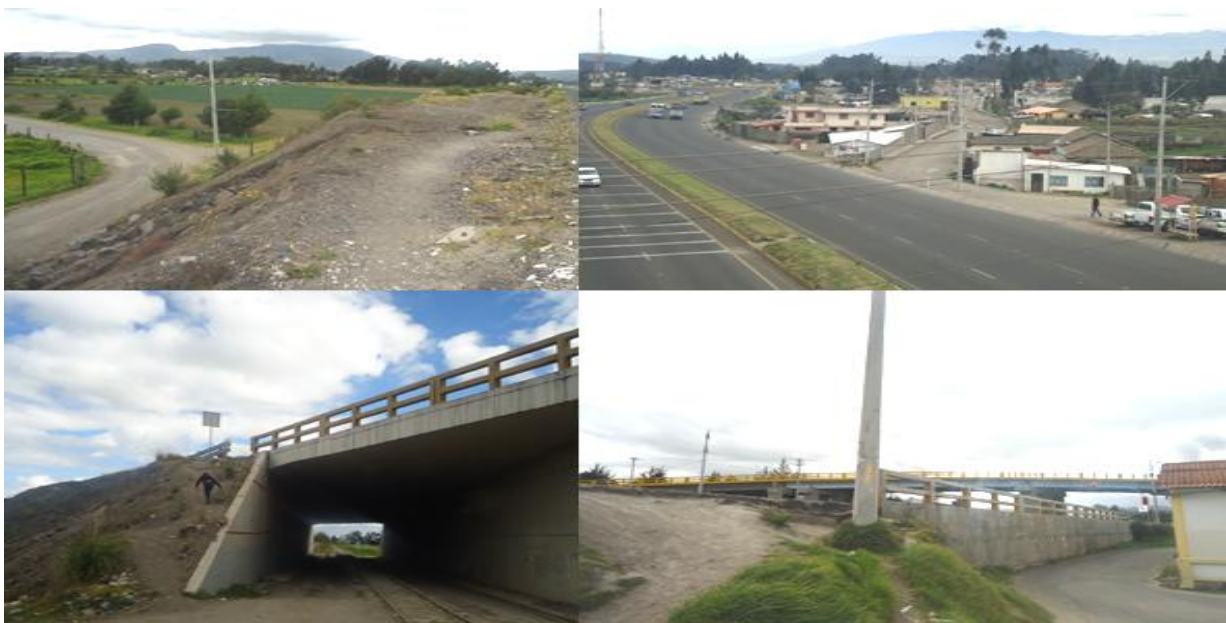
Fotografía 3. 2 Registro fotográfico de discontinuidad vial
