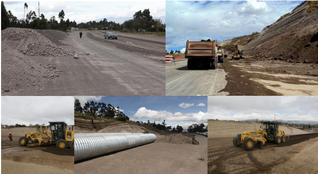
Fotografía 3. 1 Trabajos de movimientos apertura Paso Lateral Lasso – Latacunga
