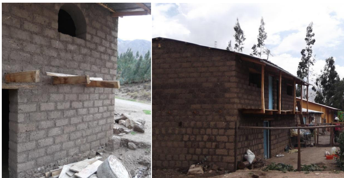
Figura 33: Huaytará: viviendas autoconstruidas Fuente: Lorena Toro Mayorga
