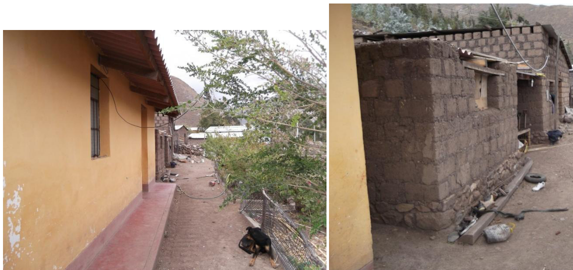
Figura 30: Huaytará: Vivienda nueva y adecuaciones a espacios preexistentes
