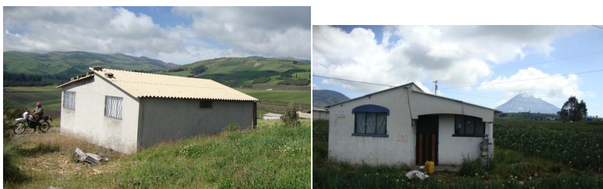
Figura 26: Quero: viviendas deshabitadas
