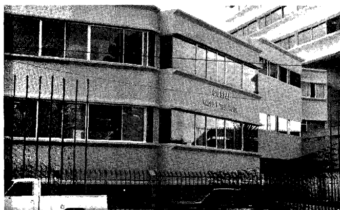
Departamento de Televisión de CIESPAL en funcionamiento
