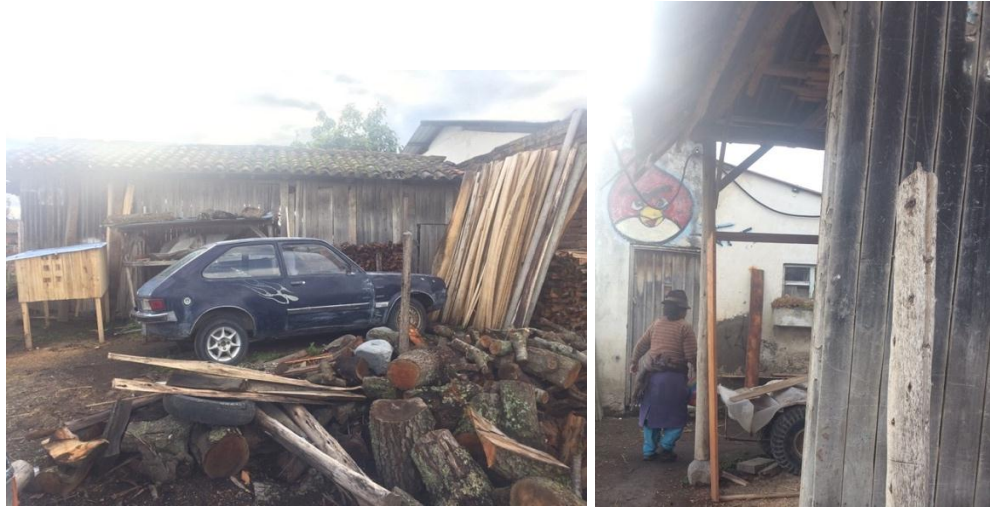
Fotos 4.53. – 4.54. Garaje y entrada principal. Fuente: Trabajo de campo.
