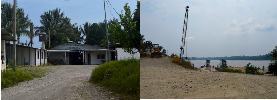
Foto 4.4. Campamento (izquierda) y rampa de carga-descarga (derecha). Fuente: trabajo de campo.
