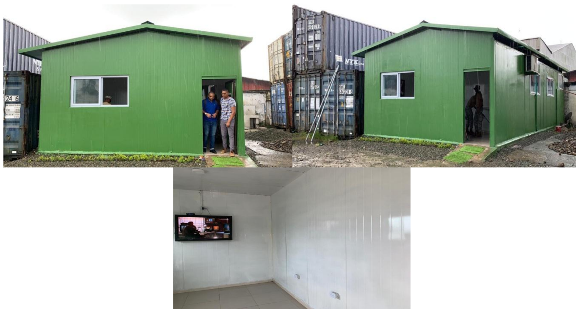
Foto 6. Casa modelo que donará la Sociedad Portuaria Regional de Buenaventura a las comunidades de Juanchaco y La Barra. Fuente: registro fotográfico de EBCR (s.f.)
