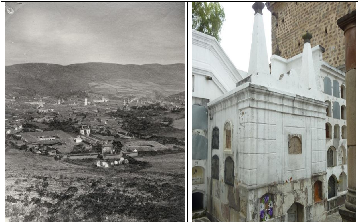
Figuras 21 y 22. A la izquierda, la Recoleta de El Tejar en la década de 1860. Detrás de ella y en primer plano se observa el cementerio. Fuente: ANF. A la derecha, una de las pocas estructuras antiguas que subsiste en el Cementerio de El Tejar en la actualidad. Fuente: ALZ.
