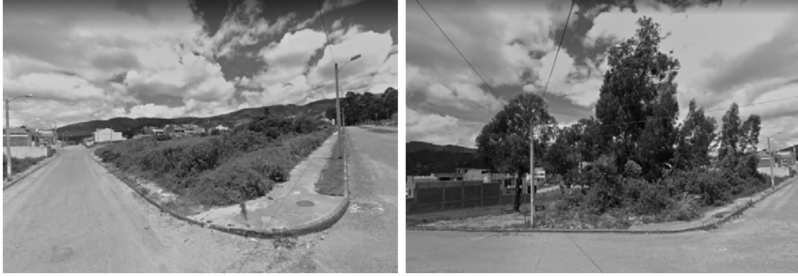
Figura 4.8. Vacío 3SA y 13SA (Barrio Sol de los Andes) Fuente: Google Maps
