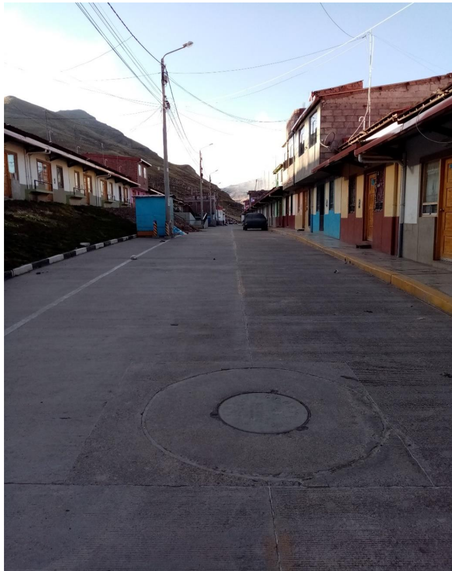
Fotografía 7 Calle vacía de la nueva Morococha
