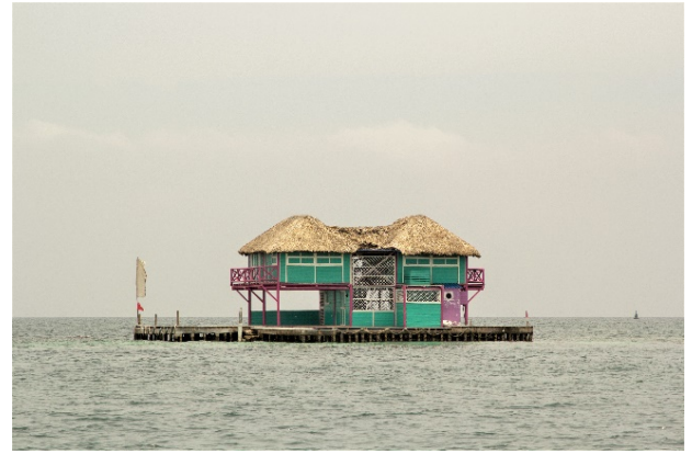
Figura 3.5. Casa de recreo sobre pilotes artificiales. Fuente: Trabajo de campo
