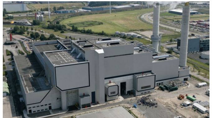
d. Planta incineradora – Ámsterdam
