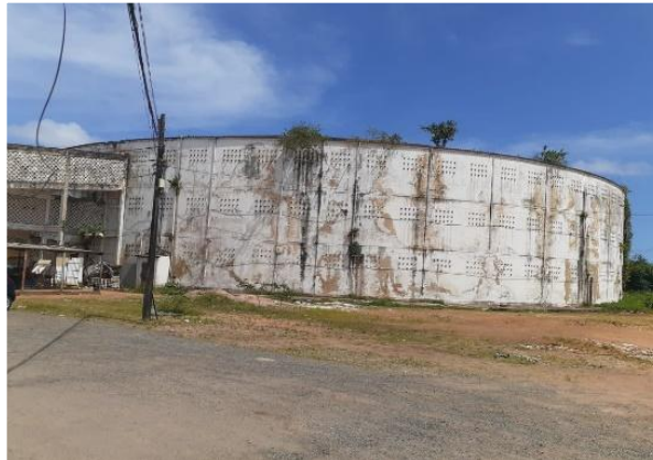
Figura 5 - Fachada externa do módulo IV (Penitenciária Lemos Brito)
