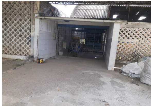
Figura 6 – Galpão das Oficinas de Trabalho - entrada principal (Penitenciária Lemos Brito)
