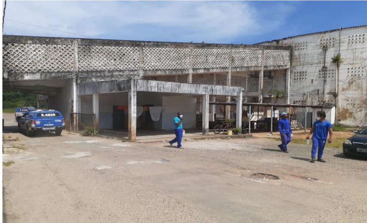
Figura 13 - Presos trabalhadores na área externa (Penitenciária Lemos Brito)
