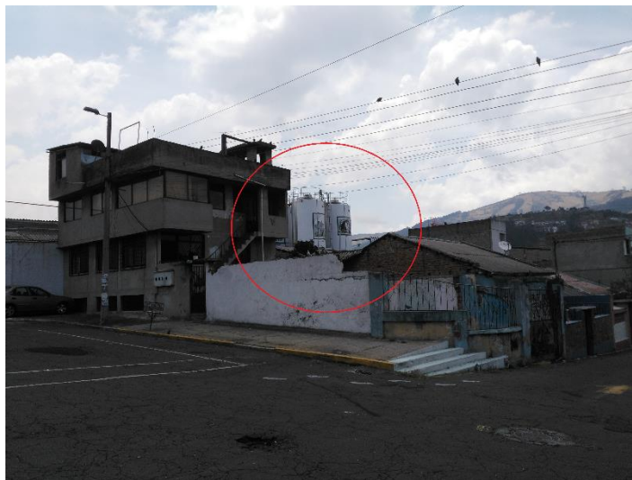
Fotografía 19. Vista de la parte posterior central de PQSA donde se visualizan los nuevos hilos de almacenamiento. Fuente: Fotografía tomada del trabajo de campo 2017
