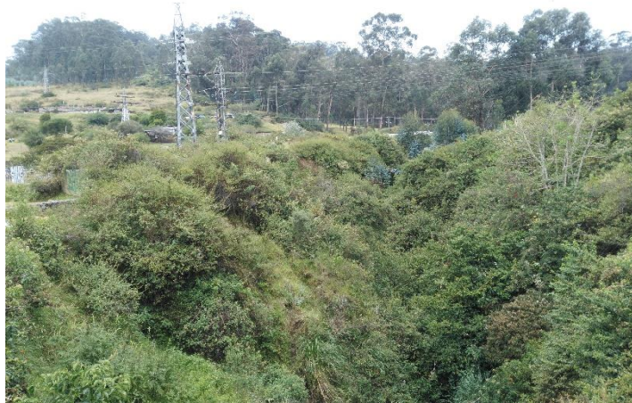
Fotografía 24. Vegetación notoria en quebrada Fuente: Fotografía tomada del trabajo de campo 2017
