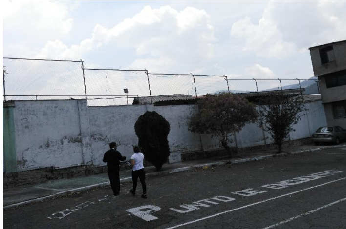
Fotografía 20. Posterior central punto de encuentro. Fuente: Fotografía tomada del trabajo de campo 2017
