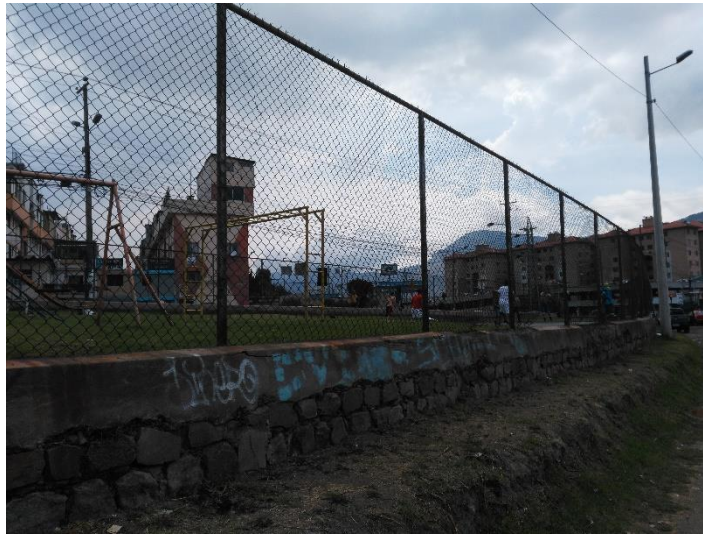
Fotografía 31. Parque perímetro frontal central continuo a PQSA. Fuente: Fotografía tomada del trabajo de campo 2017
