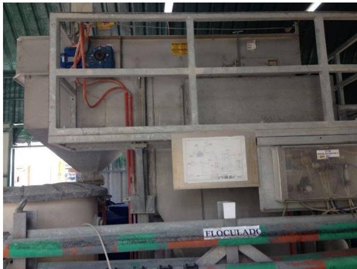
Fotografía 5. Área del DAF. Fuente: Fotografía tomada del trabajo de campo 2017
