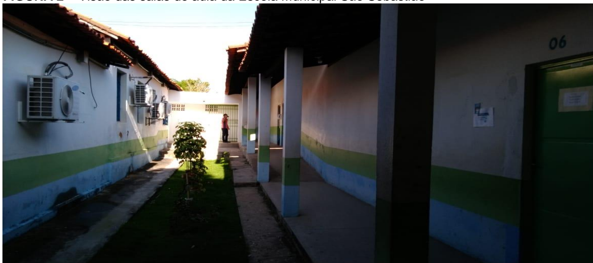
FIGURA 2 – Visão das salas de aula da Escola Municipal São Sebastião
