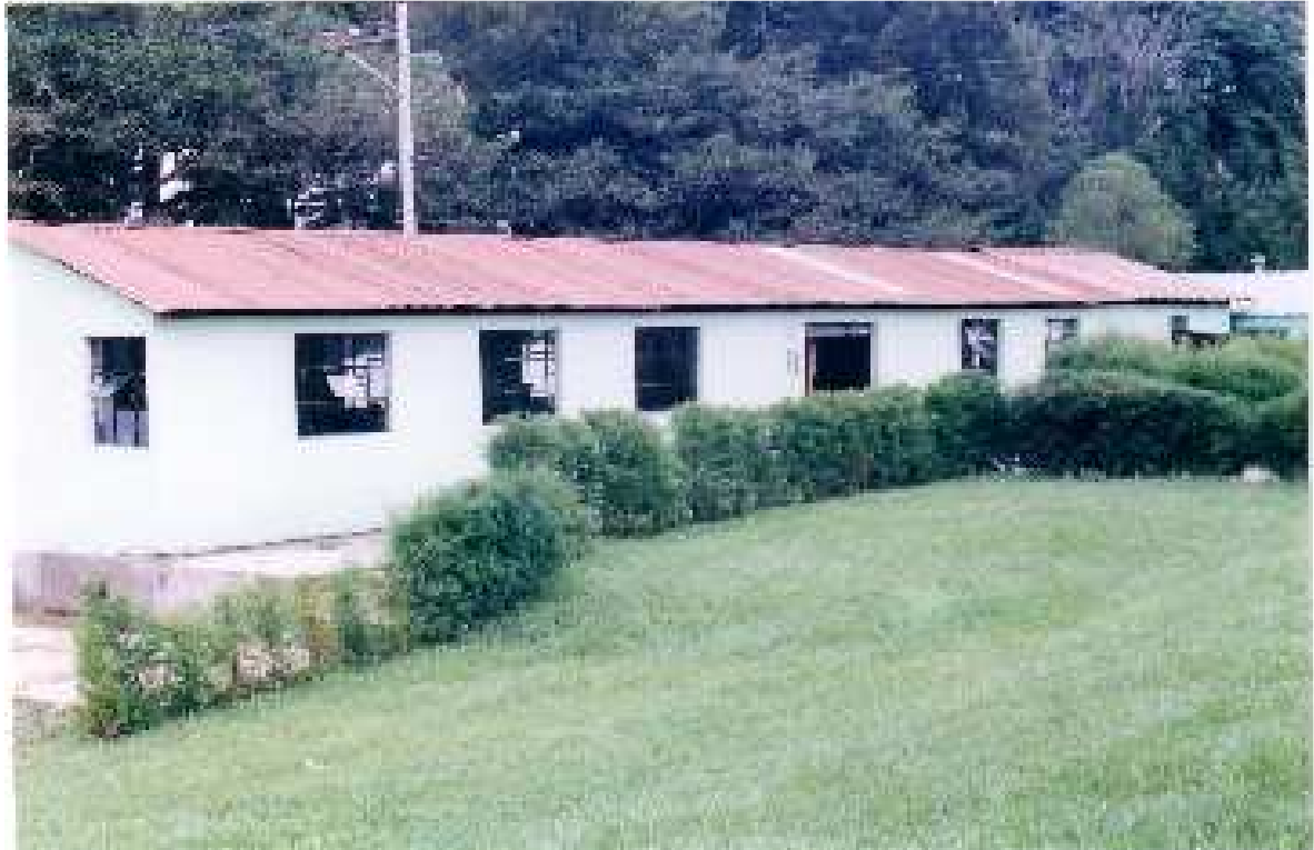
Instalaciones, Escuela Pedro Molina
