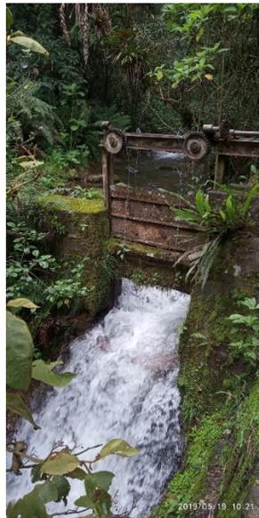
Imagen 22. Compuerta bocatoma
