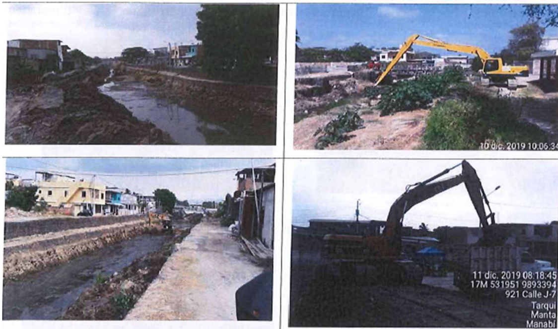
Foto 2.10 Limpieza del cauce del río Manta
