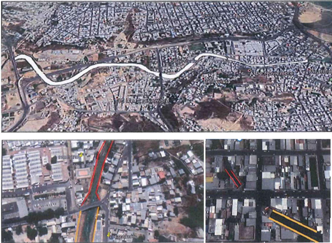
Foto 2.3 Estrangulamiento de cauce debido a asentamientos
