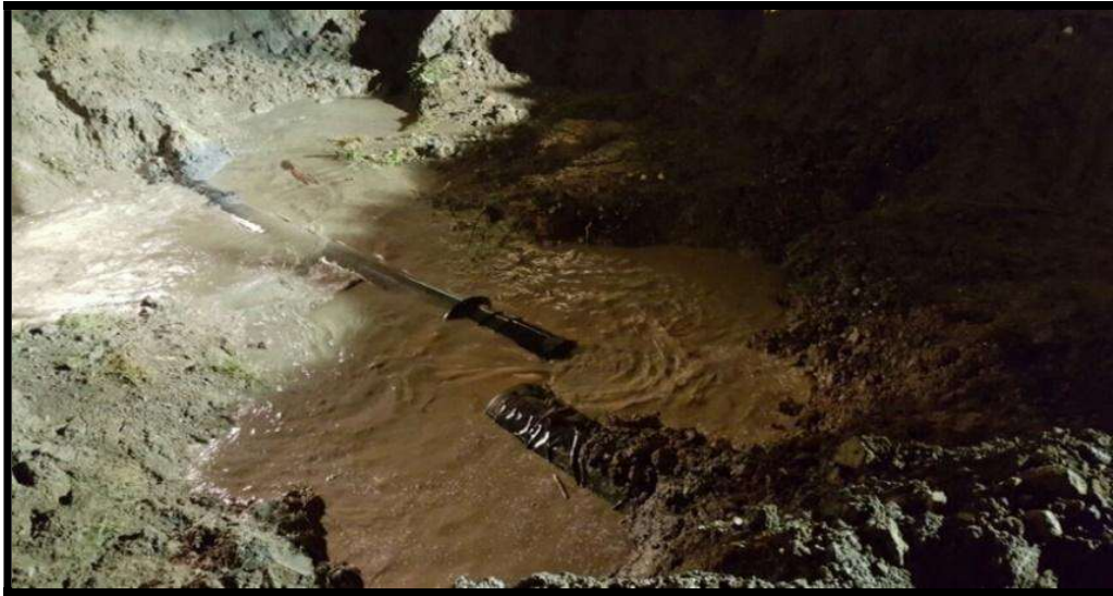
Foto 2.5 Daños en la tubería hacia PTAP Ceibal
