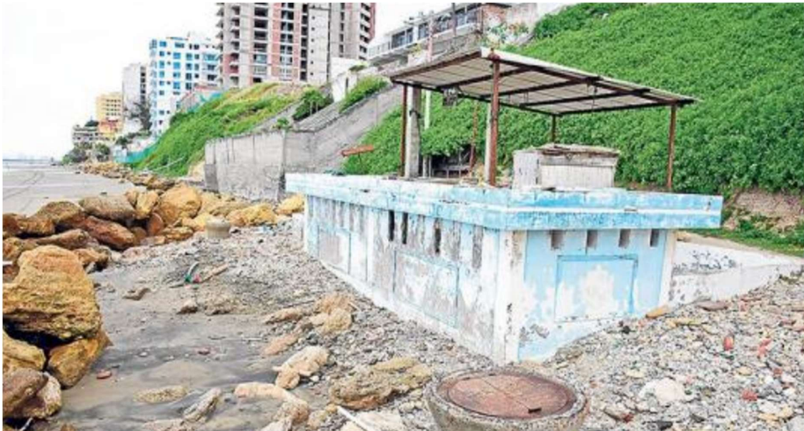
Foto 2.9 Estación de bombeo Umiña
