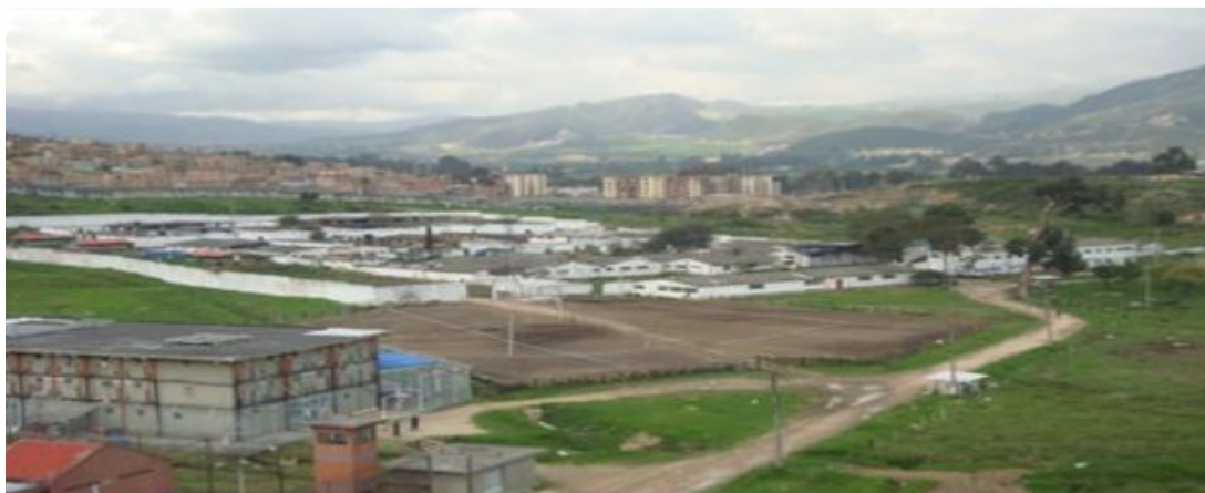
Foto 2.4 Panorámica Estructura 2. Pabellón Justicia y Paz. Establecimiento de segunda generación
