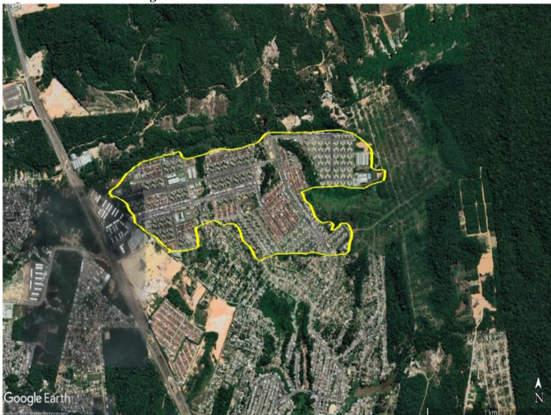
Figura 19 - Vista área do RVM I e II – Manaus/AM
