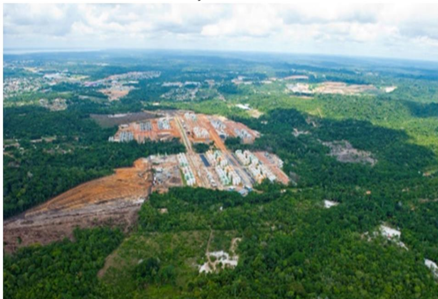
Foto 13 - Construção do RVM I – Manaus/AM
