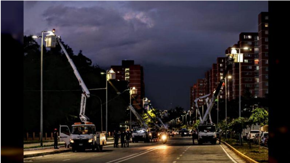
Jornada para sustitución de alumbrado público
