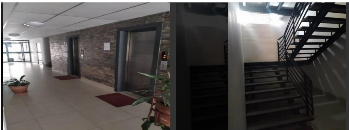
Entrada principal, amplias con ventilación natural
