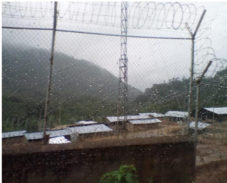
Foto 4.1. Enrejado del campamento minero “La Esperanza”, 2017
