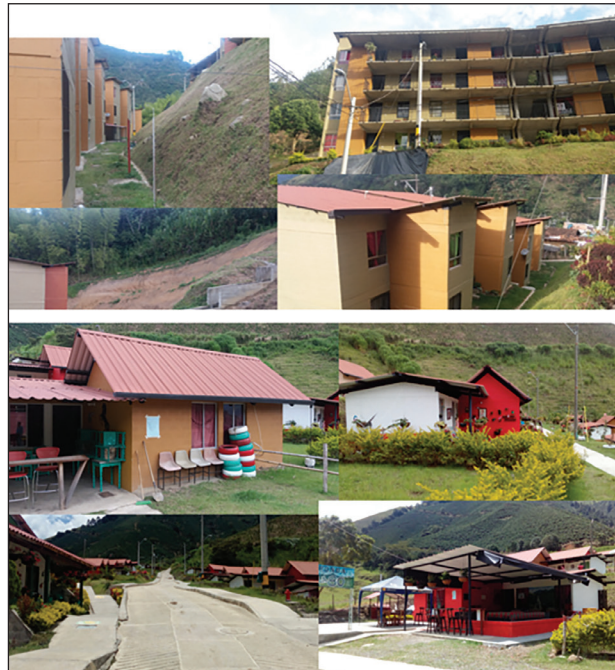
Figura 1. Fotos de los proyectos de reconstrucción de vivienda (La Florida y La Pradera)
