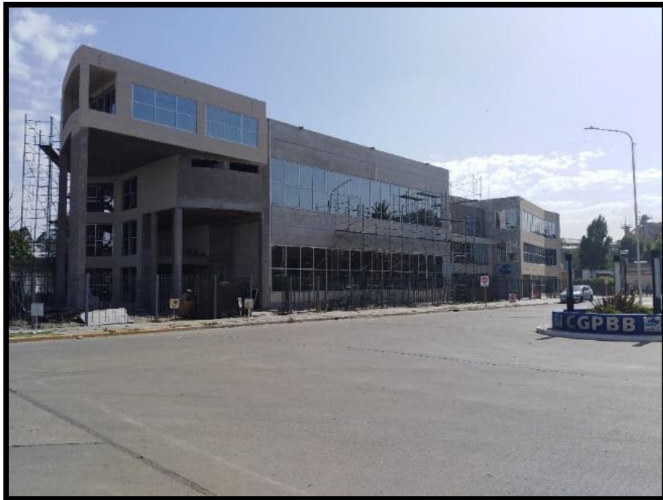
Figura 25: Ampliación de oficinas del CGPBB
