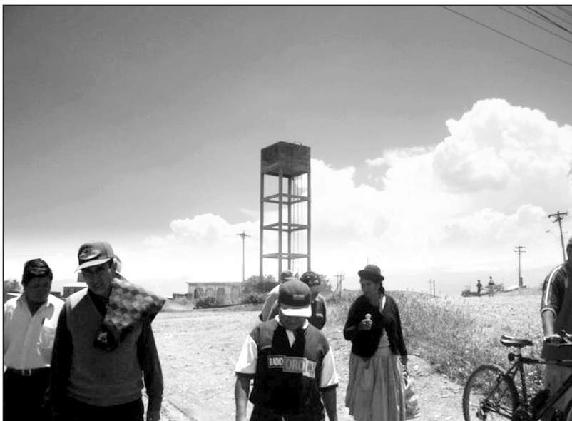
Figura 4.2. El nuevo tanque de agua en Nueva Cruz de Mayo
