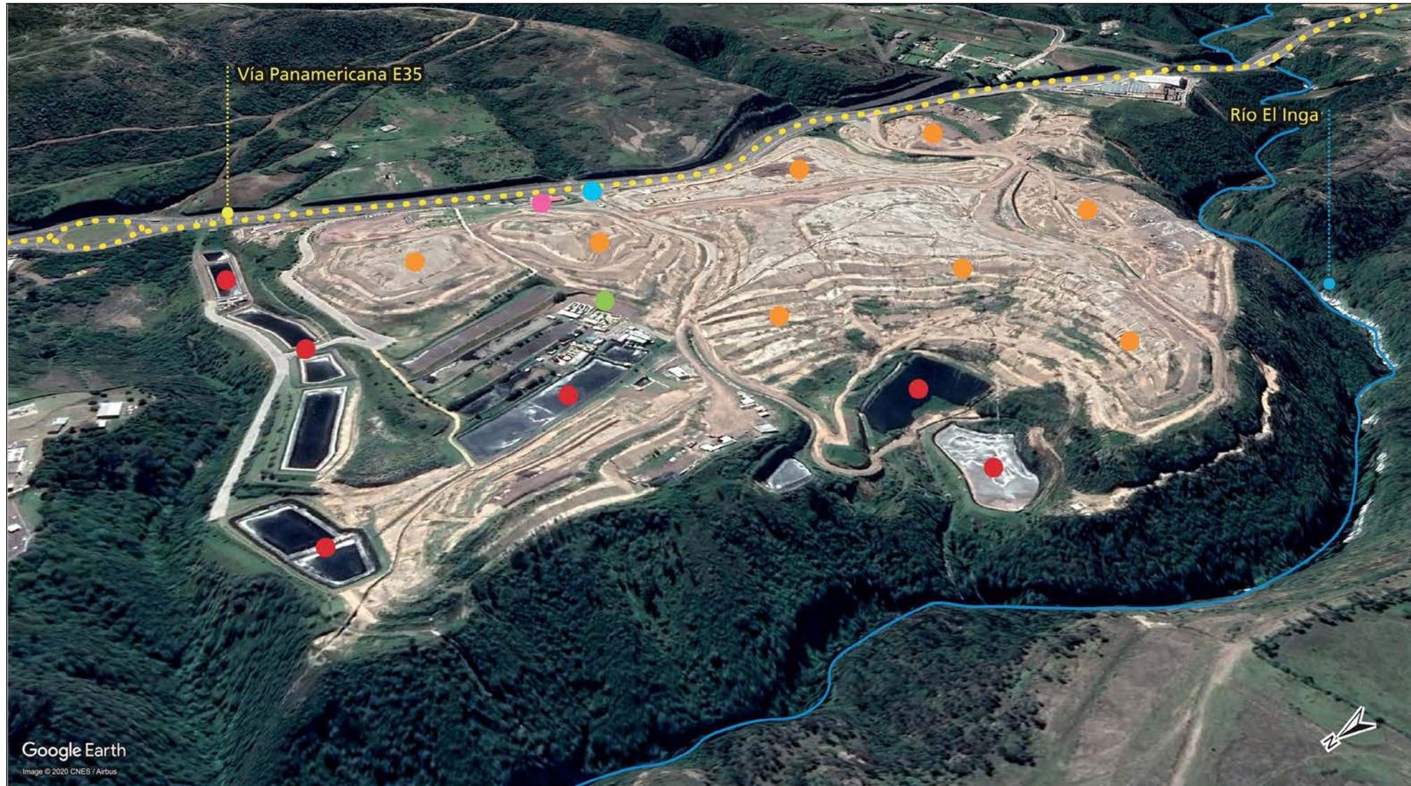
Mapa 26. Imagen aérea del relleno sanitario y las piscinas de lixiviados
