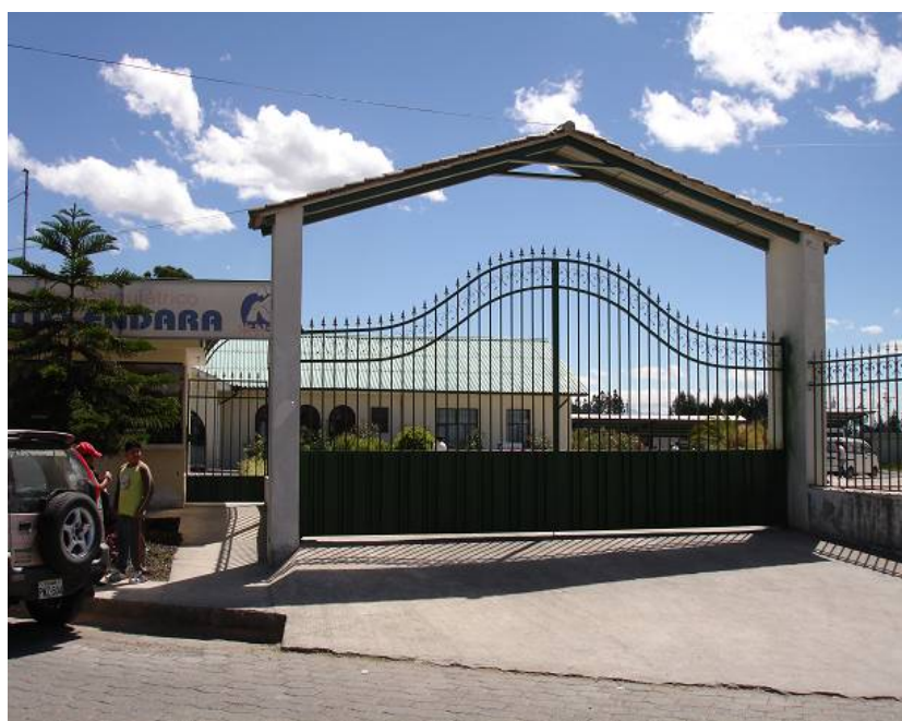
Hospital Psiquiátrico Julio Endara: Puerta de ingreso al Hospital. Julio de 2.009 (V.g. ingreso).
