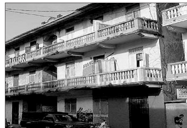
Fotografía 2 "Casas condenadas" (Panamá centro)
