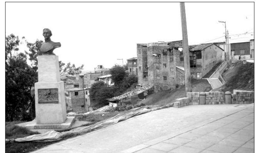
Imagen 2 Construcción informal en altura en sectores populares de Bogotá (2009)
