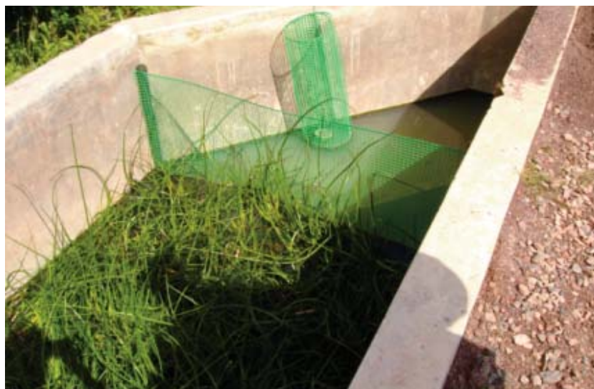
Fotografía No. 4.14 Fase final del sistema de tratamiento
