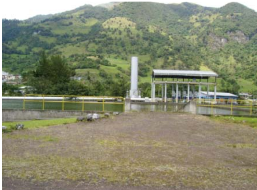
Fotografía No. 3.21 Estación elevadora EMAAP-Q, Papallacta
