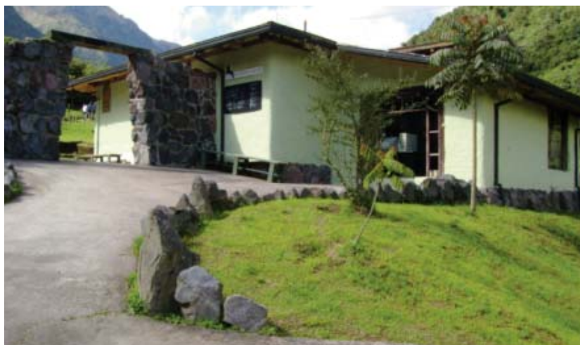
Fotografía No. 3.24 Instalaciones de Termas de Papallacta
