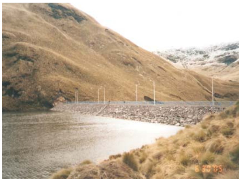
Fotografía No. 3.22 Presa Salve Faccha EMAAP-Q, Oyacachi
