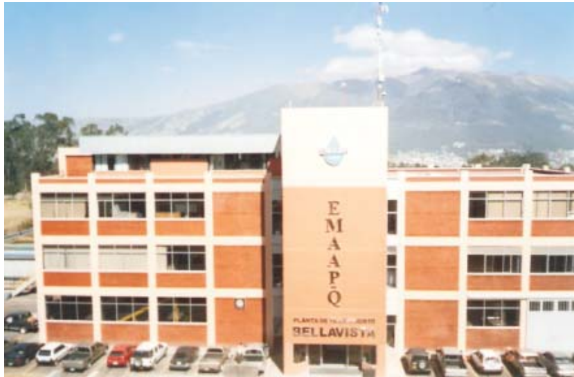
Fotografía No. 4.3 Planta de tratamiento Bellavista, EMAAP-Q
