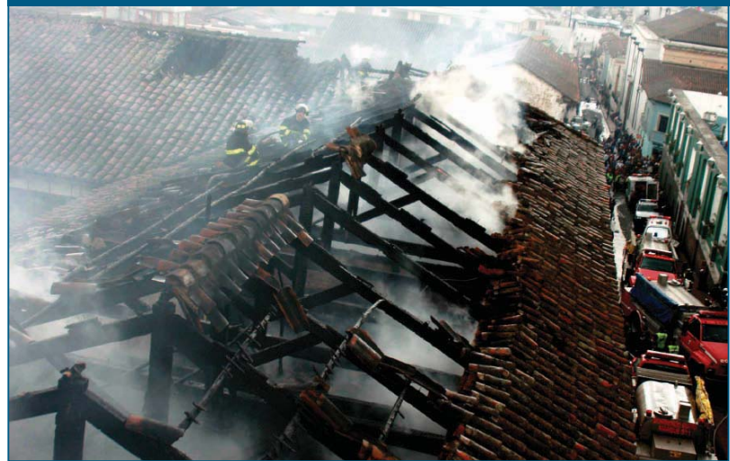
Fotografía N.º 4.8 Incendios calles Cuenca y Rocafuerte
