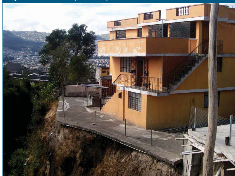
Fotografía N.º 2.2 Casa sobre la quebrada La Raya
