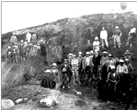
Figura 3: Excavación en Cerro Narrío, Cañar
