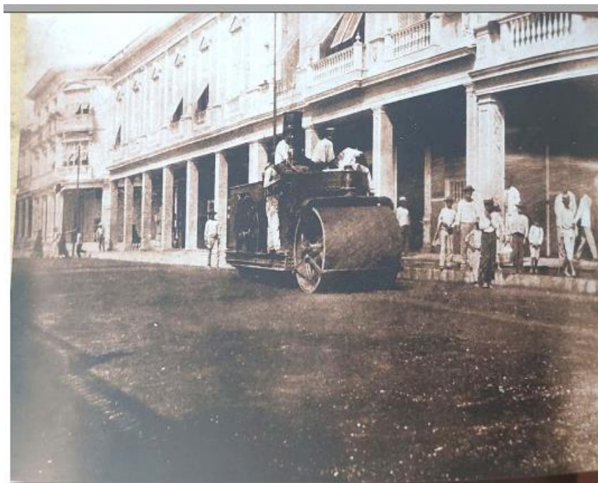
Figura 2.21. Pavimentación de calles en Guayaquil
