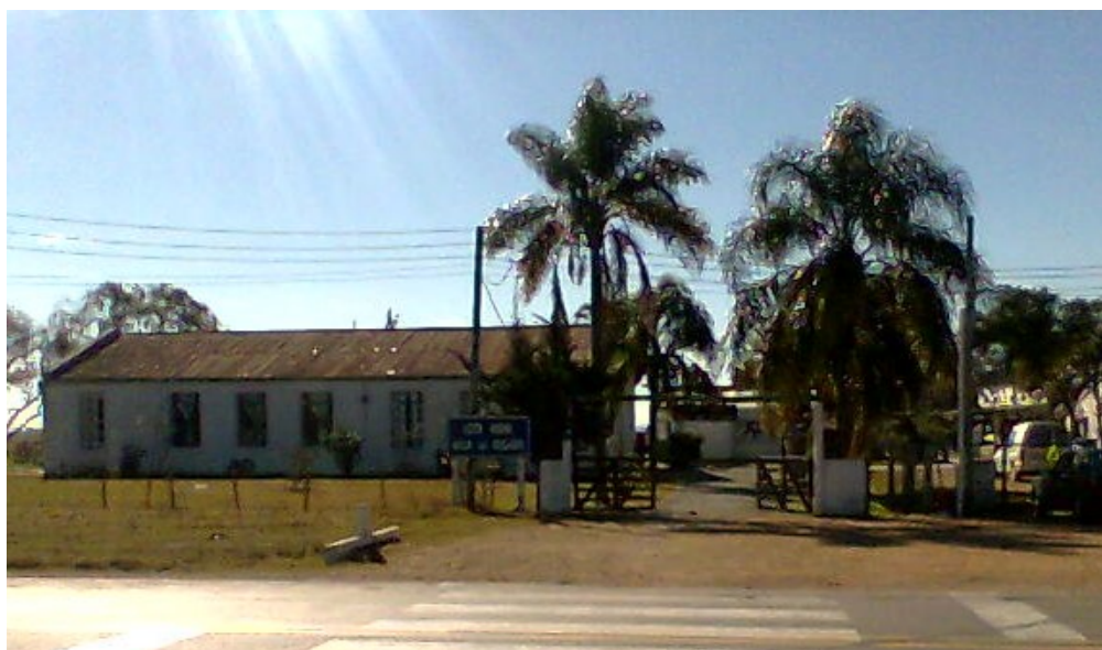
Figura 3. Fachada del liceo rural
