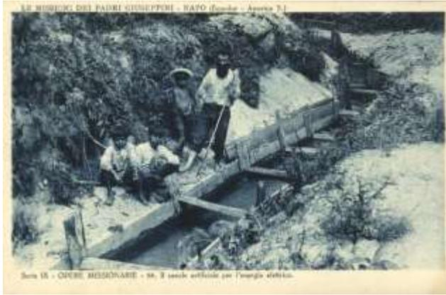
El canal artificial para la energía eléctrica
