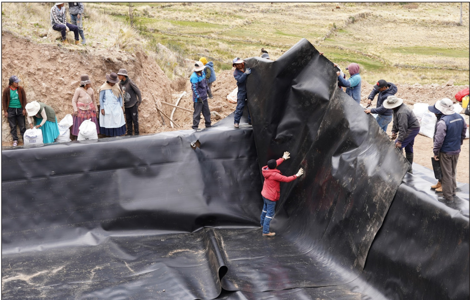
Figura 6. Ayni en Chigani Alto para la construcción de la qutaña o reservorio de agua
