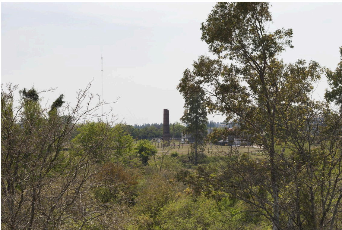
Figura 35: Restos de la chimenea del Saladero Santa María. Fuente: Paisaje Contemporáneo del Barrio Nuevo Paysandú
