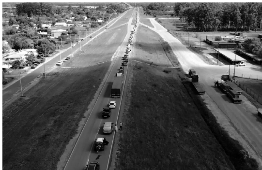
Figura 10: Ramal 10 - Ruta 3 y Avenida Roldan 19 . Vista aérea. Se observa el Puente “Seco”, la vía del tren, y los terraplenes. Se constata la diferencia de nivel entre el Ramal de acceso al puente y el barrio en el primer tramo. Figura 11: Puente “Seco” 20 . Se observa la Avenida Roldán y los terraplenes sobre los que se construyó el Ramal. Figura 12: Ramal 10 - Ruta 3 21 . Vista aérea. A los lados de la ruta se observan los terraplenes construidos. Más arriba se observan las transversales por las que se accede al barrio desde el Ramal 10, y al fondo el horizonte. Del lado izquierdo de la imagen, al sur, se observa la Avenida de las Américas, paralela al ramal, y las casas del barrio. Del lado derecho de la imagen se observa la calle interior de acceso al establecimiento de ANCAP. Figura 13: Ramal 10 -Ruta 3 y Puente Internacional General José Artigas 22 . Se observa el segundo tramo en pendiente, el tramo horizontal y, lado derecho de la imagen, el cuarto tramo en pendiente. Fuente: Internet.
