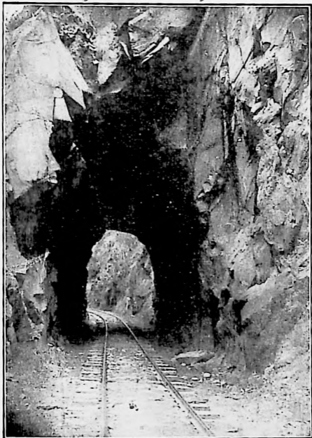
UN TUNEL EN LA ROCA MILENARIA
