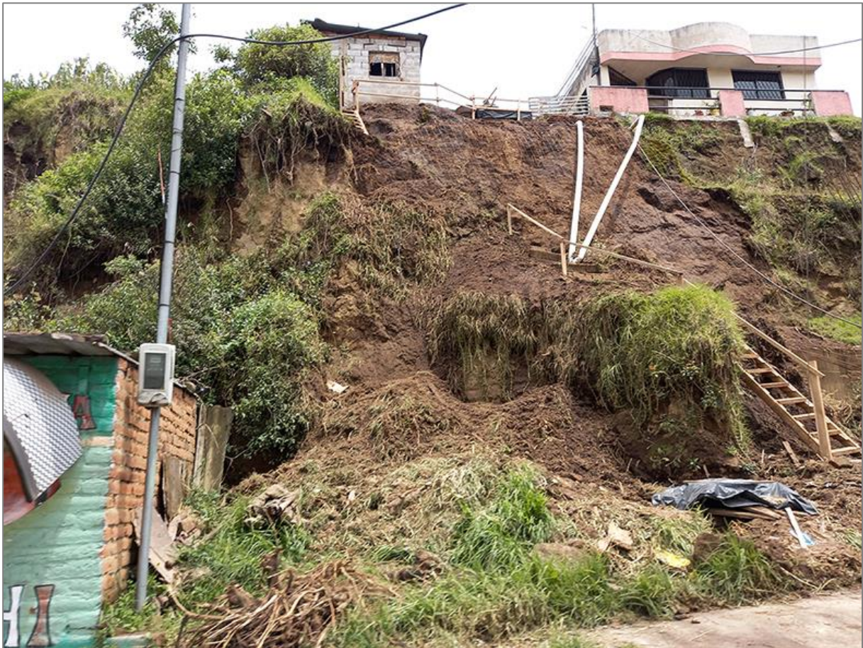
Foto 4.2. Deslizamientos de tierra en el barrio Colinas del Norte
