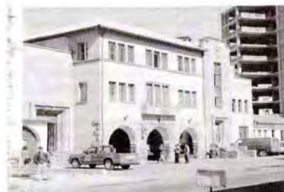
ESTACIÓN DE BOMBEROS
