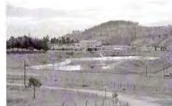
PLANTA DE TRATAMIENTO DE AGUA DE PUENGASI
