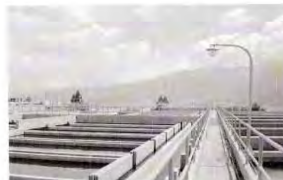
PLANTA DE TRATAMIENTO DE AGUA
