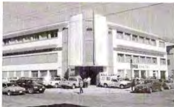
CENTRAL DE TELECOMUNICACIONES
