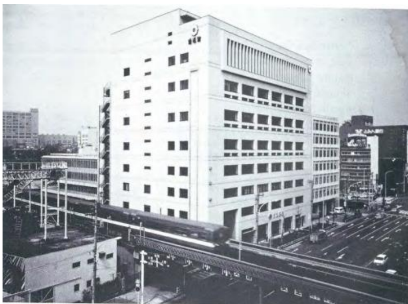
Foto 0.5 Edificio del Kodokan
