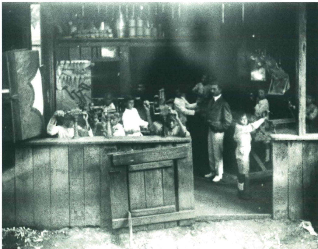
FOTO 2.1 – Oficina de Serralheria da Escola de Aprendizes Artífices do Pará, 1911. (Fonte: Foto gentilmente cedida pelo Prof. Péricles Antônio Barra Bastos, da Escola Técnica Federal do Pará.)
