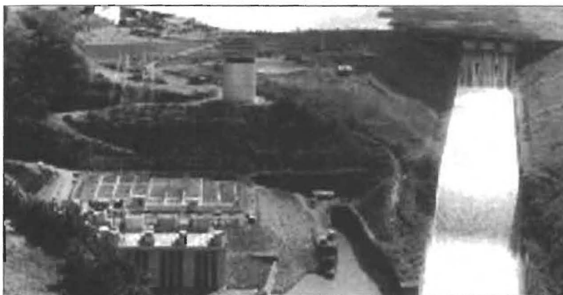
Central hidroeléctrica Daule-Peripa, Ecuador. US$ 188.5 MM
