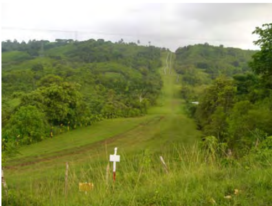
Foto 3: Sitio de rotura del Poliducto en 1998
