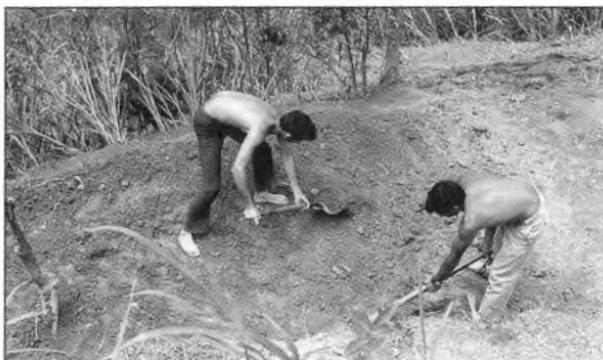
Fotografía 3 - Inicio de la excavación para el banqueo o primera terraza donde construirán la casa
